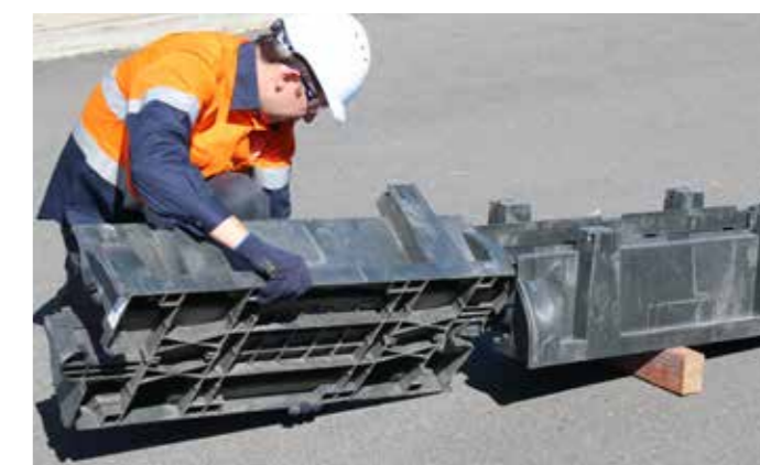
Koryta są łączone systemem hakowym (obróć i połącz)
